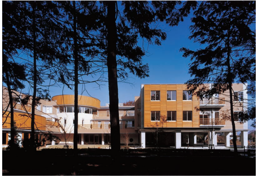
地域に開かれた施設をめざし、既存の樹木を残して囲いを設けなかった事例
