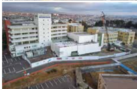
上/2021年8月 2期基礎工事中 (写真提供:フジタ) 下/2021年12月 2期躯体工事中
