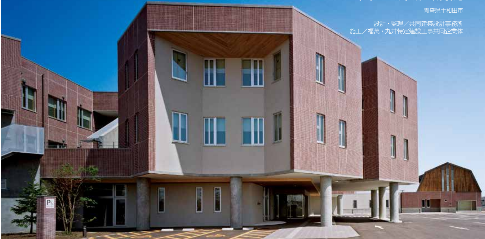
メインアプローチよりエントランスを望む。地域の伝統工芸「南部裂織」の市松柄をイメージしたタイル貼りの外観
