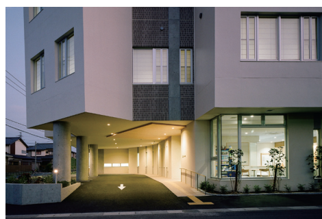
雨雪でもアプローチしやすいピロティに面した主玄関
