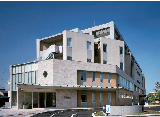
松山の地域性を生かし、分節化した壁面で構成したファサード
