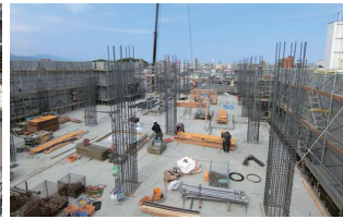
4階躯体工事状況 (写真提供: 東亜建設工業)
