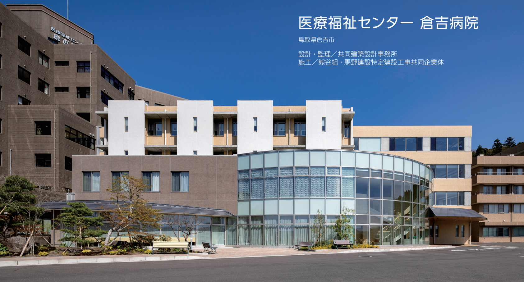
既存棟（左奥および右端）との調和を図りながら新しさを加えた増築棟
