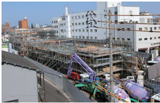
狭小地での施工状況
