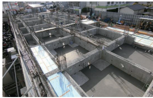
流動化処理土による基礎埋戻し状況
